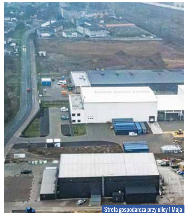
Wschodnia obwodnica - 1 etap budowy drogi Racibórz - Pszczyna
