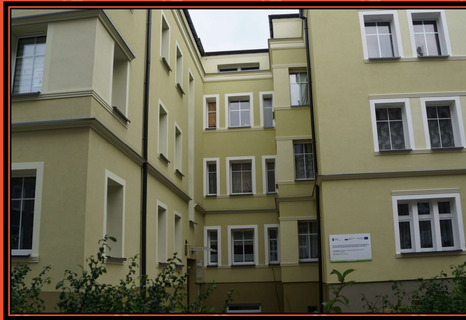
Zmodernizowana kamienica przy ulicy Czokoladowej
