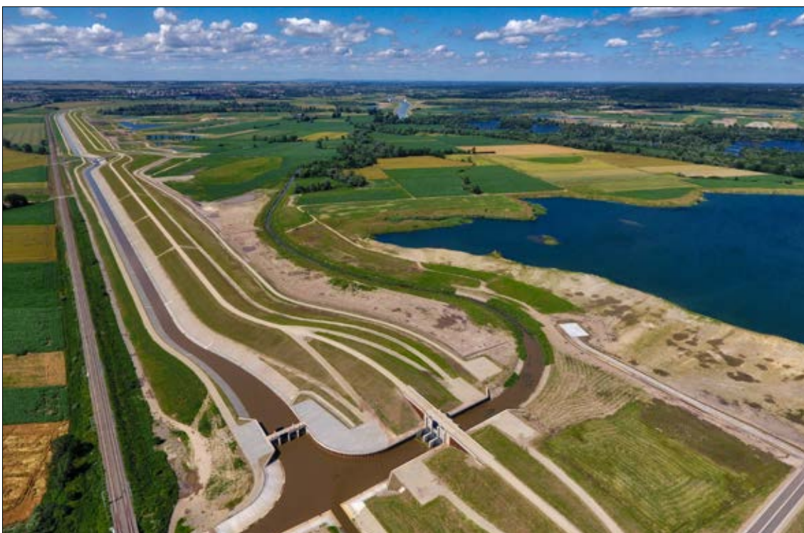
Boczna zapora zbiornika na wysokości Bieńkowic i Tworkowa Boční hráz nádrže Ratiboř v oblasti Bieńkowic a Tworkowa, fot. Wojciech Olanin
