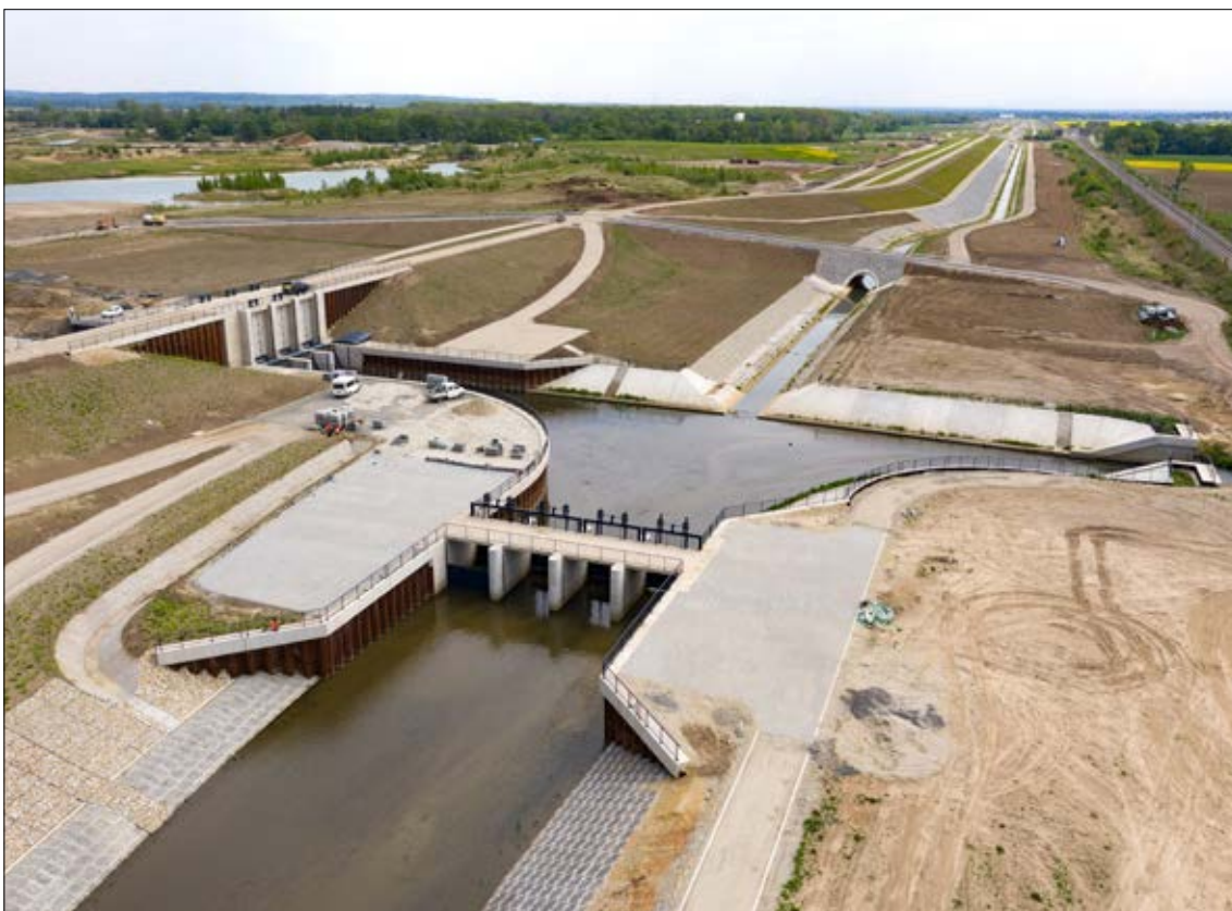
Nádrž Ratiboř – boční nádrž na straně obce Křižanovice a rozdělení vod řeky Ciny, fot. tiskové materiály Budimex S.A.
