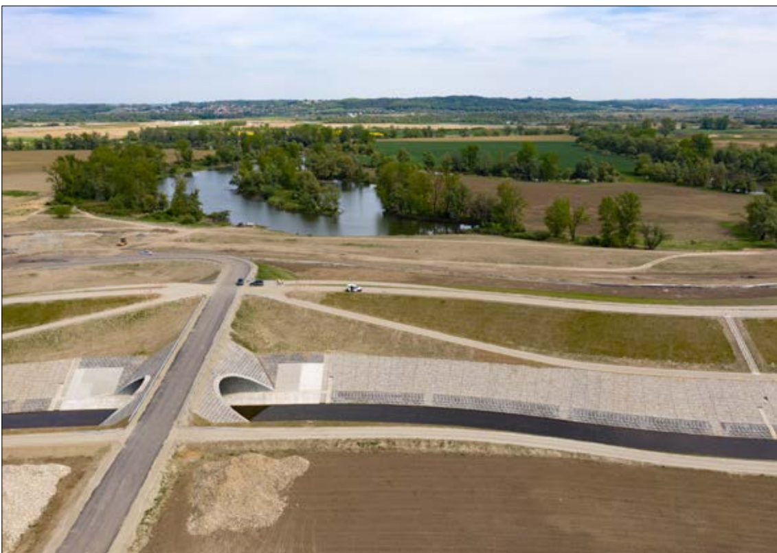
Nádrž Ratiboř – boční nádrž na straně obce Křížanovice a nové koryto Ciny, fot. tiskové materiály Budimex S.A.
