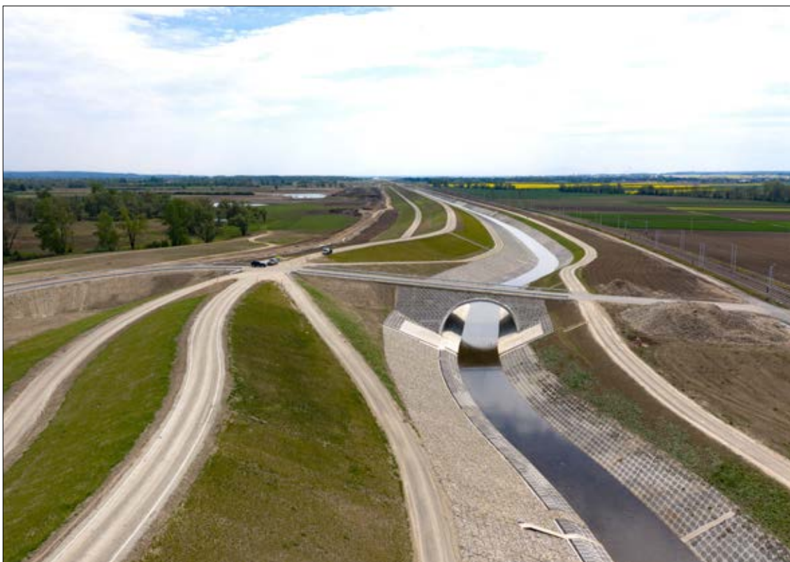
Zbiornik Racibórz, zapora boczna – od strony gminy Krzyżanowice oraz nowe koryto Psiny, fot. materiały prasowe Budimex S.A.
