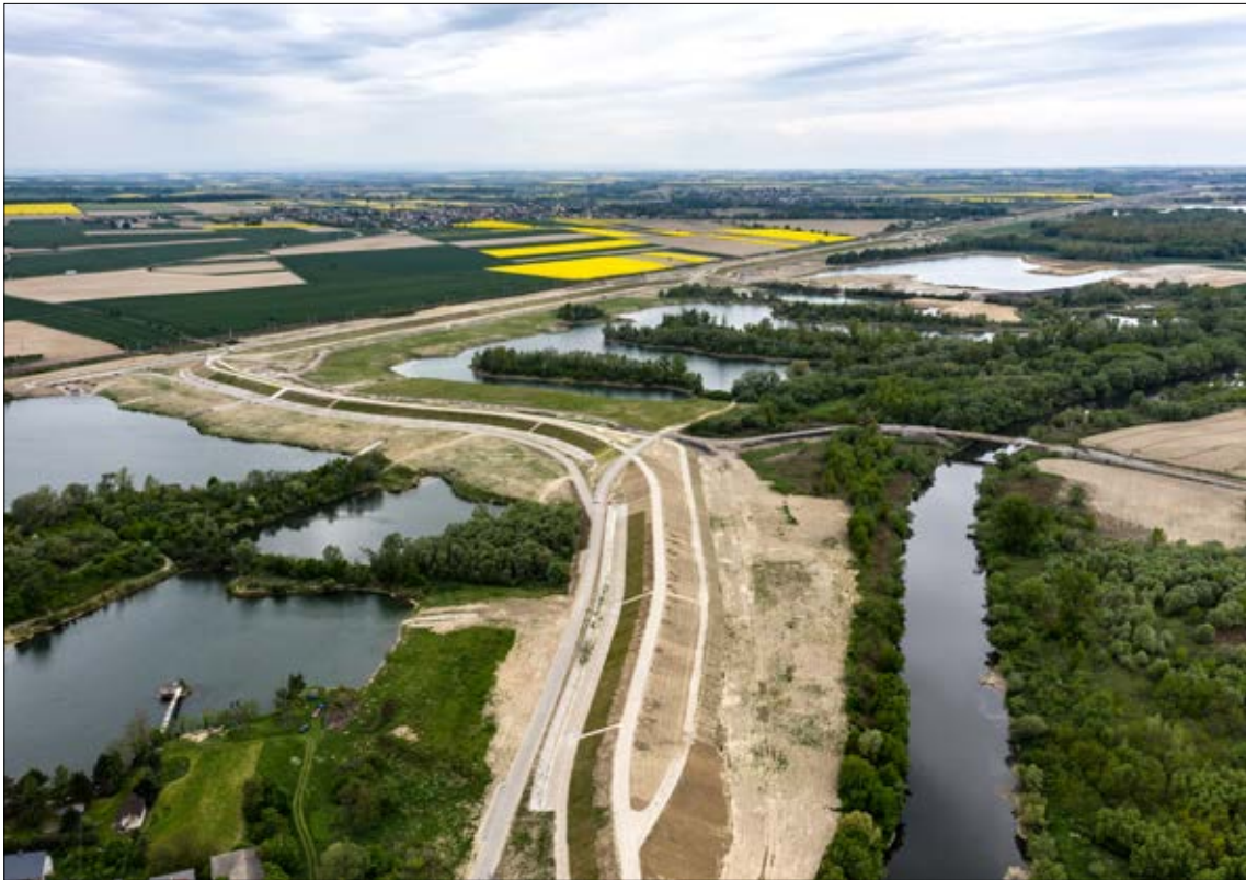
Zapora boczna zbiornika Racibórz w rejonie Tworkowa i Krzyżanowic, fot. materiały prasowe Budimex S.A. Boční hráz nádrže Ratiboř v oblasti Tworkowa a Křižanovic, fot. tiskové materiály Budimex S.A.
